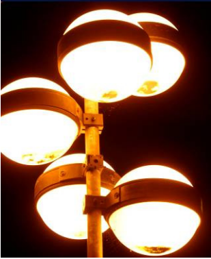
Bild 4: Kugellampen, die ineffizienteste Aussenbeleuchtung
