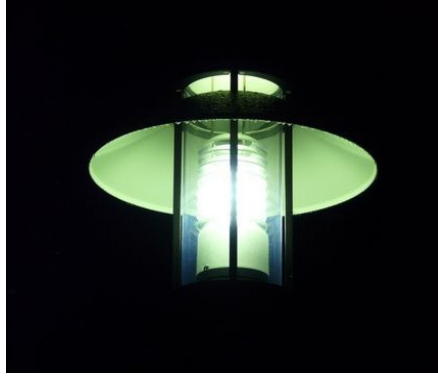
Bild 5: Seitlicher Lichtaustritt suboptimal
