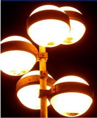
Bild 4: Kugellampen, die ineffizienteste Aussenbeleuchtung
