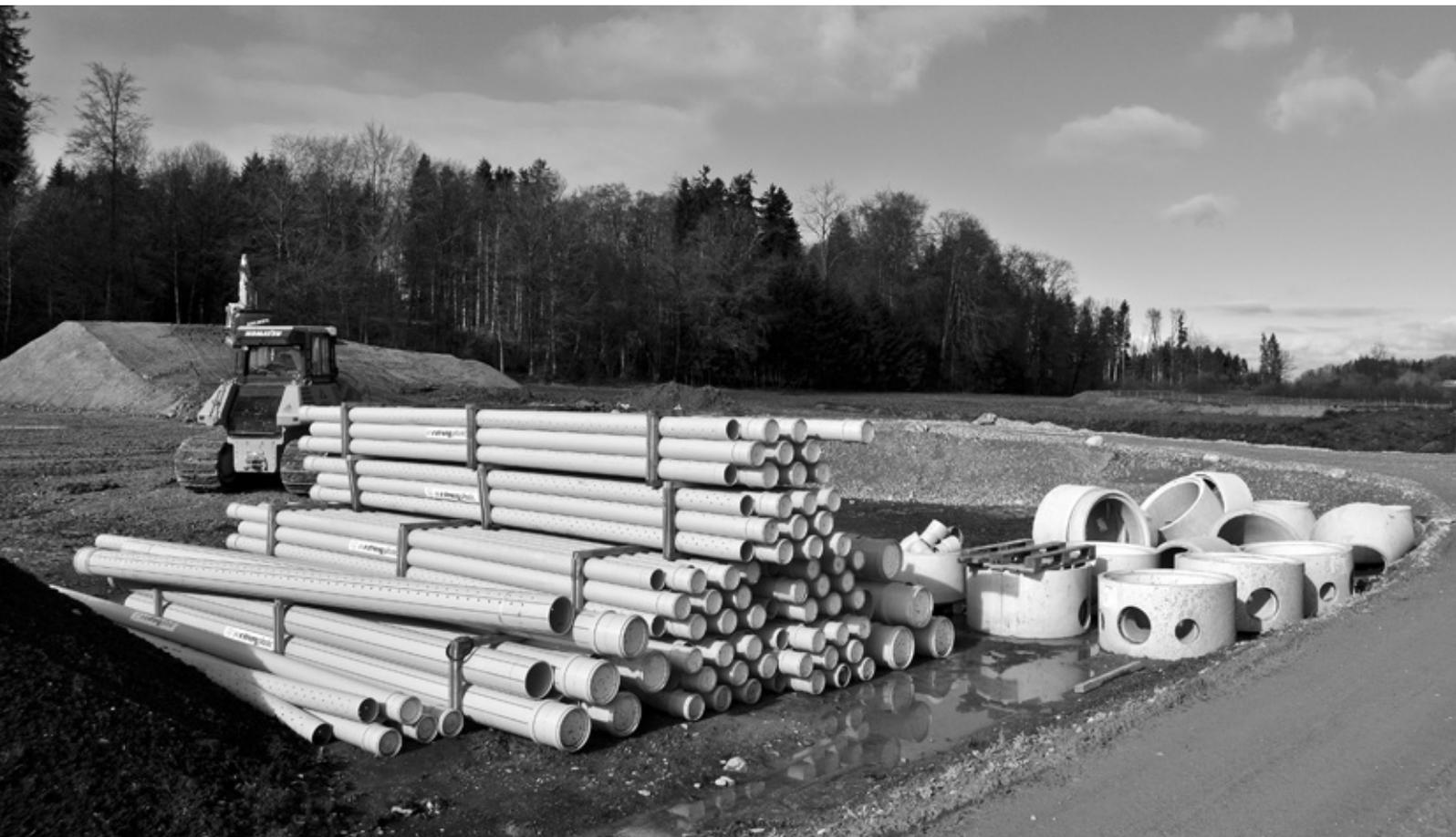
Sickerleitung, damit der Boden nicht zu nass bleibt nach Niederschlägen
